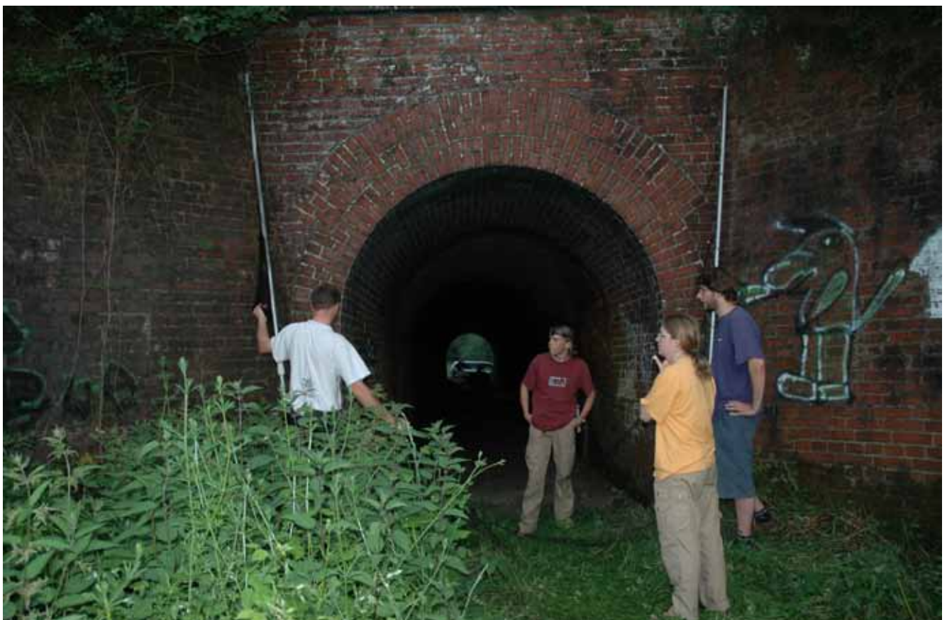
POSE D'UN FILET PHILIPPE WEGNEZ
